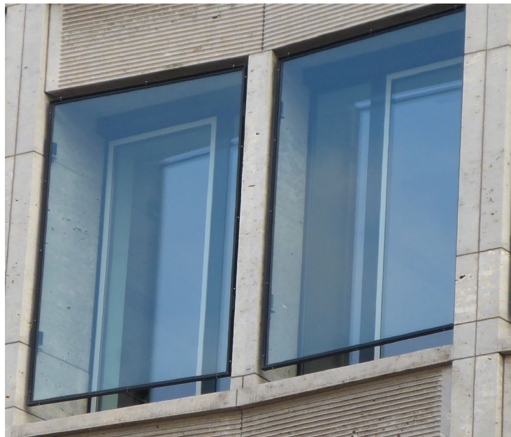
Abb. 8 Fenster mit Prallscheibe
