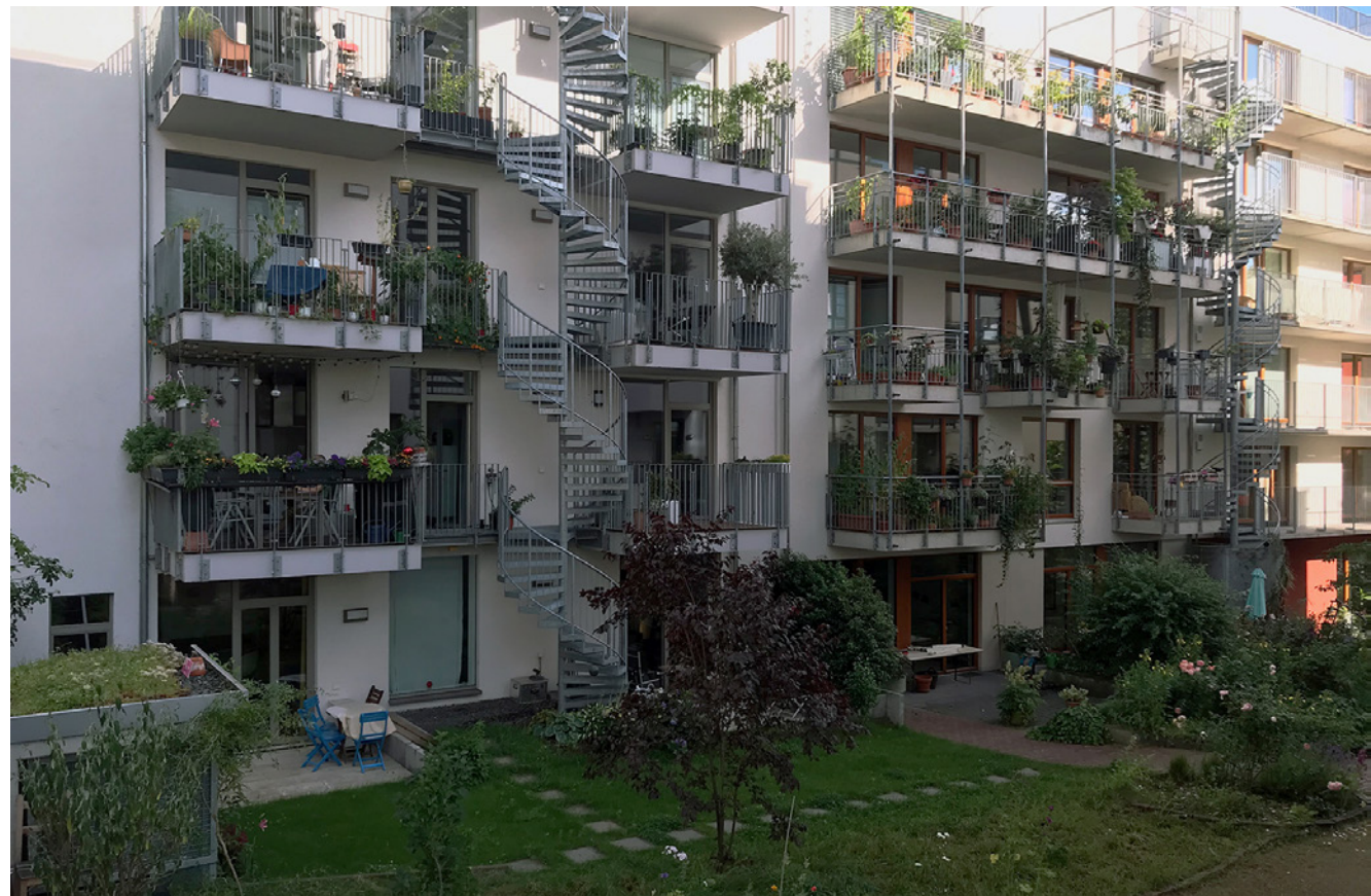
Gartenseitige Fluchttreppe als zweiter Rettungsweg (Naxos-Areal).
