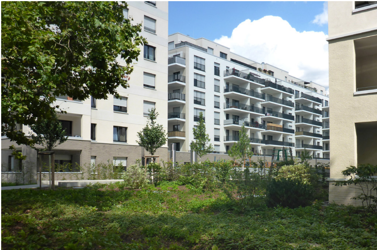
Begrünter Hofbereich über der Tiefgarage bei einer Wohnbebauung im Nordend-West. Im Bereich der Baumneupflanzungen im Hof wurde die Vegetationstragschicht erhöht.
