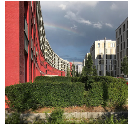
Bebauung als Lärmschutz zum Fehenheimer Industriegebiet im Offenbacher Hafen
