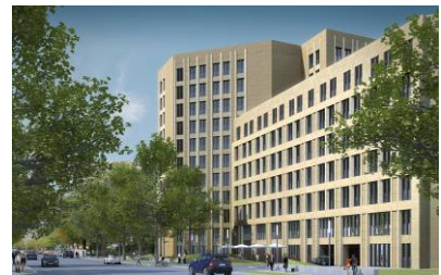
Aufstockung und Anbau Triton- Haus
