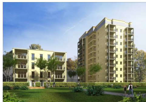
Umbau und Sanierung Wohnhaus und Neubau MFH, Heilmannstr. 52
