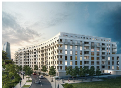
Mehrfamilienhaus Ferdinand-Happ-Straße Bild: WENTZ & CO. GMBH
