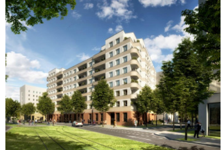
Mehrfamilienhaus Da Vinci Garten Bild: Nassauische Heimstätte GmbH
